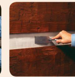
5. Travailler pour s'assurer de l'étanchéité du joint en haut et en bas de la fente colmatée.
