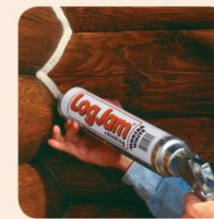
2. Recouvrir le boudin en mousse avec Log Jam® au pistolet.
