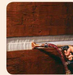
3. Recouvrir le matériau de renfort avec Log Jam® au pistolet.
