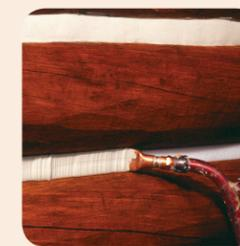
3. Recouvrir le boudin en mousse avec Log Jam® au pistolet.
