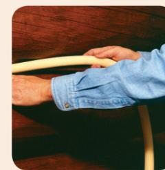
1. Installer la bande auto-agrippante dans l'espace à colmater entre les rondins teints et propres.
