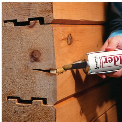
2. Recouvrir le boudin en mousse avec Log Builder® au pistolet.
