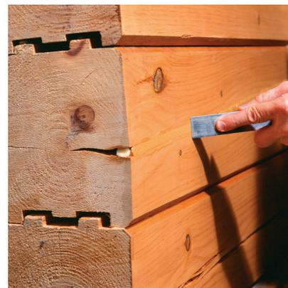
3. Recouvrir le boudin en mousse avec Log Builder® au pistolet.
