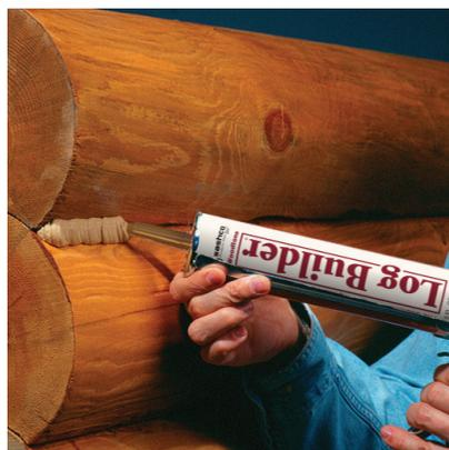
1. Appliquer Log Builder® dans des joints propres et teintés.\*
