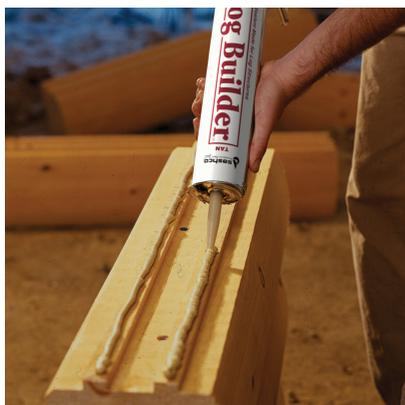
Appliquer le(s) joint(s) selon les instructions du fabricant de la maison en bois rond. Empiler le rondin suivant et recommencer. Ne pas laisser le mastic sécher avant l'empilement.
