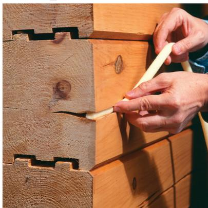
1. Installer le boudin en mousse dans une craquelure propre et teintée à la profondeur appropriée. (Voir les Instructions de base pour l'application).
