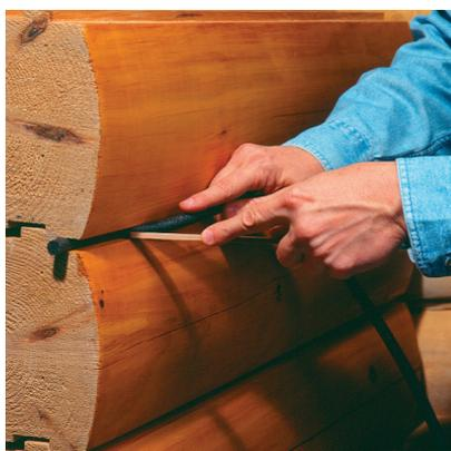
1. Installer le boudin en mousse dans l'espace à colmater de rondins teintés et propres..
